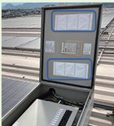
設備へのG-ブレス施工例
